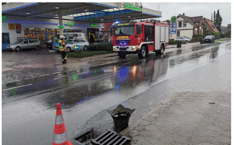
13.09.2023 - TH1 Wasser auf Straße
